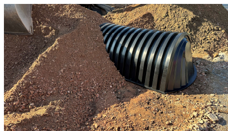
Tunel AS-KRECHT OPTIMAL ve stavebním výkopu
