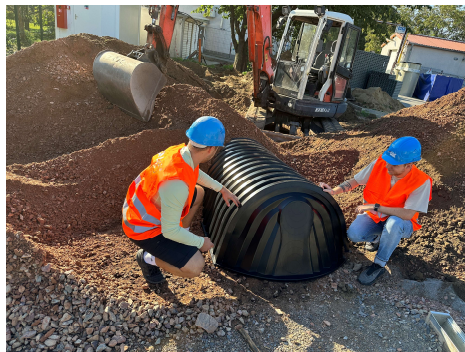
Zasypání tunelových prvků
